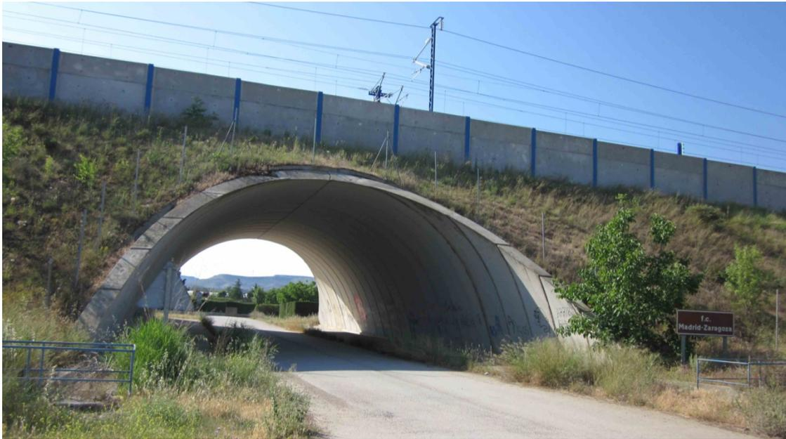
Imagen 10. Trazado del AVE sobre talud y paso inferior de vía pecuaria
